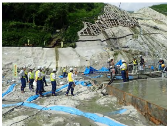
減勢工コンクリート打設状況の研修
