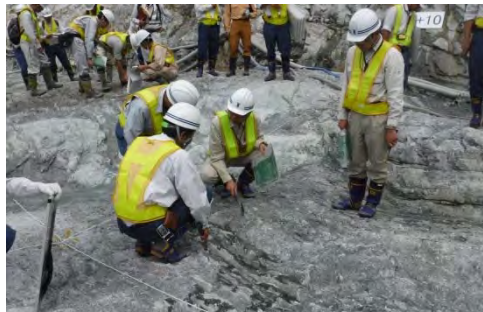
基礎地盤検査のようす (ハンマーの打撃音等で岩盤の状態を確認)
