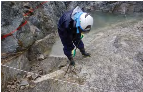
岩盤清掃のようす (バールを用いて浮石を除去)
