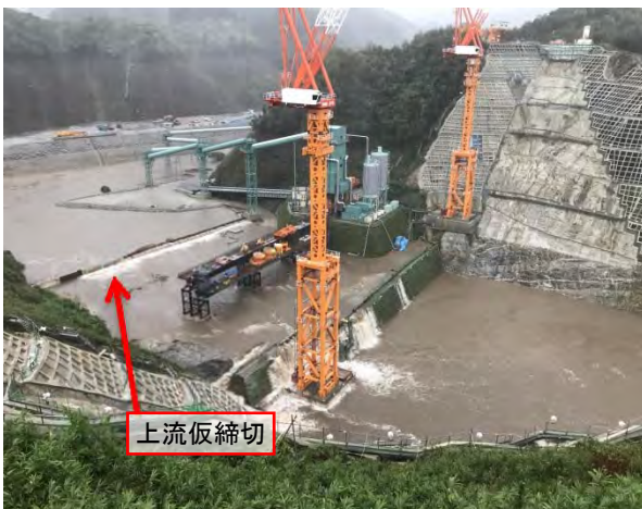
上流仮締切越流時の様子
