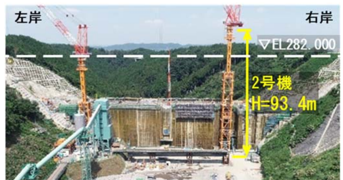
タワークレーン2号機高さ変更後(令和2年8月)
