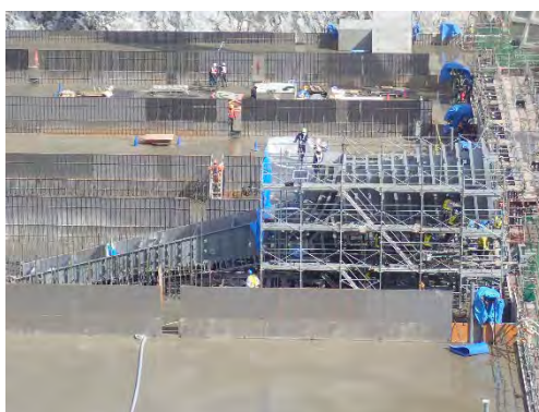
常用洪水吐きの設置のようす
