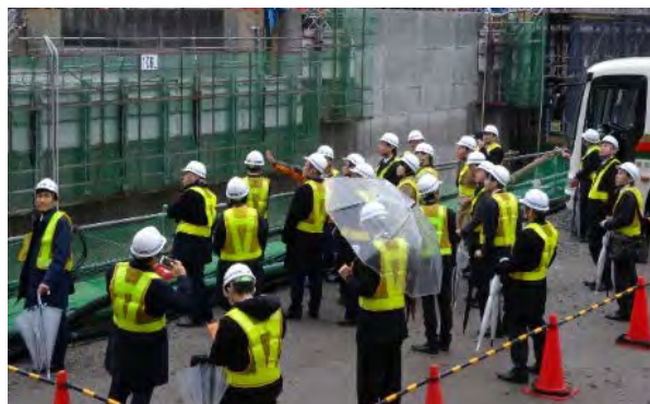
コンクリート打設現場での視察のようす
