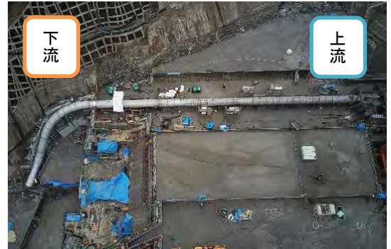
利水放流管の設置完了状況（全景）
