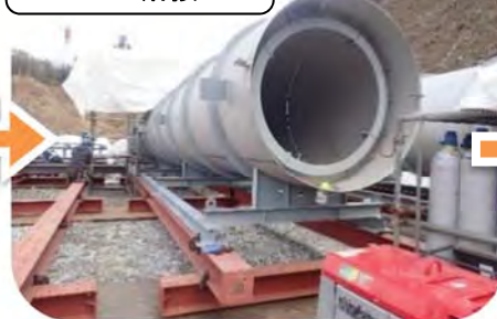
②仮組立ヤードでの溶接
