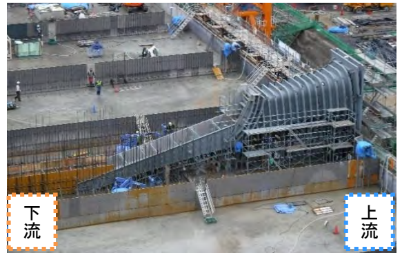
常用洪水吐き放流管の全景
