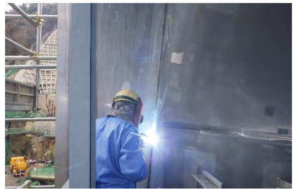
ダム堤体上で溶接される常用洪水吐き放流管
