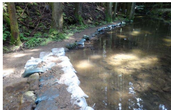
復旧された通路のようす
