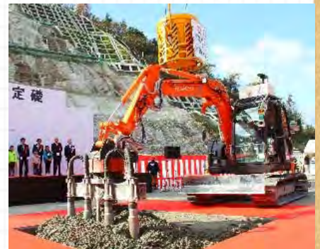
無人のバイバックが締固めするようす
