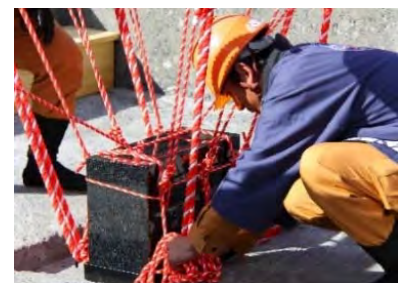
定礎石を設置
