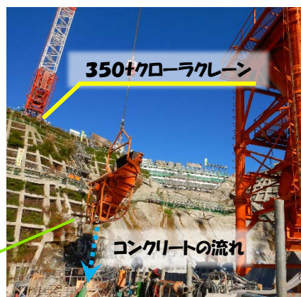
350tクローラクレーンでの打設のようす
