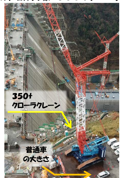
350tクローラクレーン
