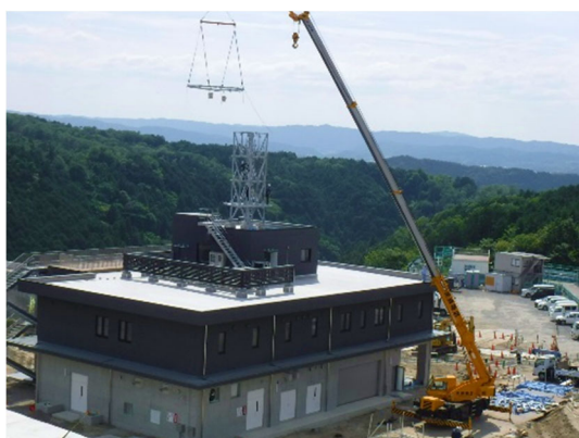
鉄塔の据付作業のようす
