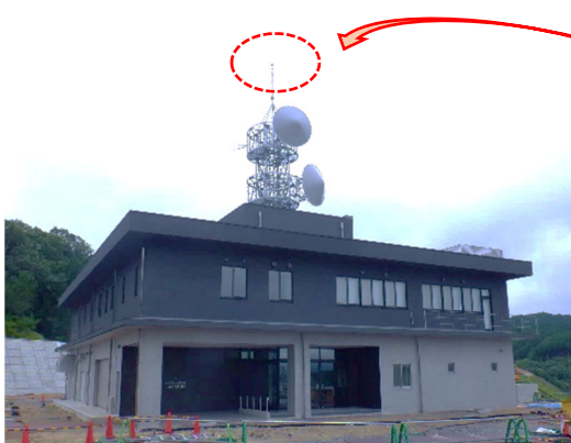
鉄塔・パラボラアンテナ据付完了後
