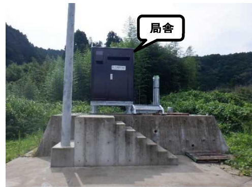
局舎の設置完了
