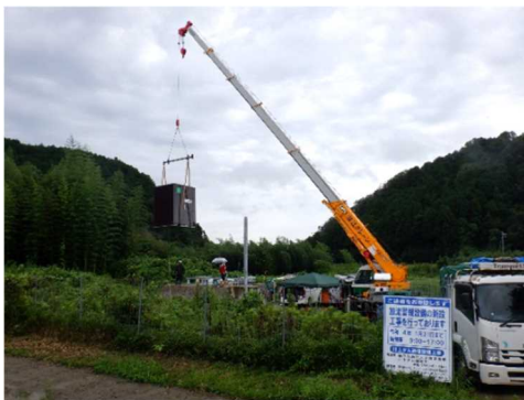
局舎の設置作業のようす
