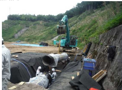
管水路施工状況
