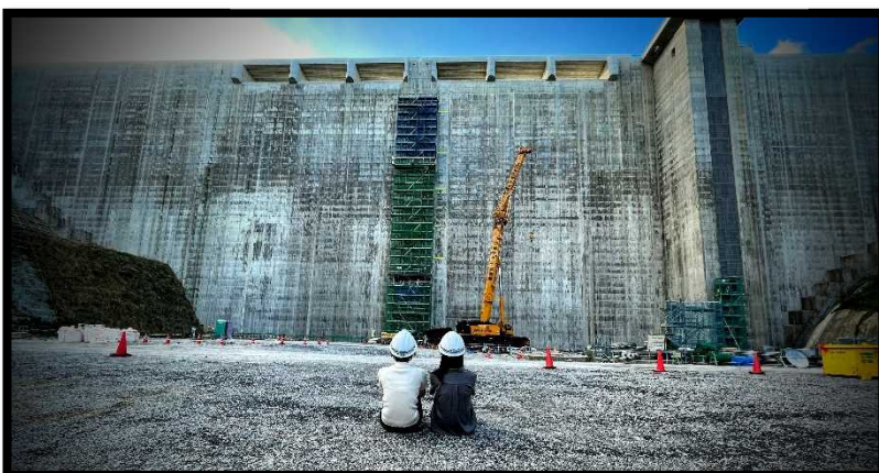
貯水池内からダムを見上げる様子
