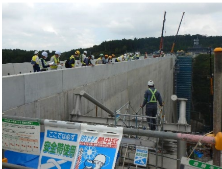
安全パトロール実施状況
