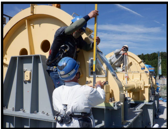
据付後の寸法検査のようす
