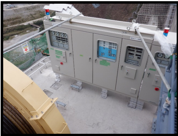
機側操作盤据付のようす
