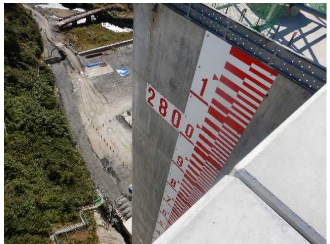
設置が完了しました
