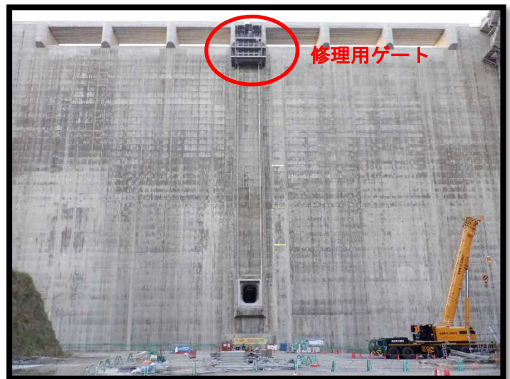
修理用ゲート据付完了後のようす
