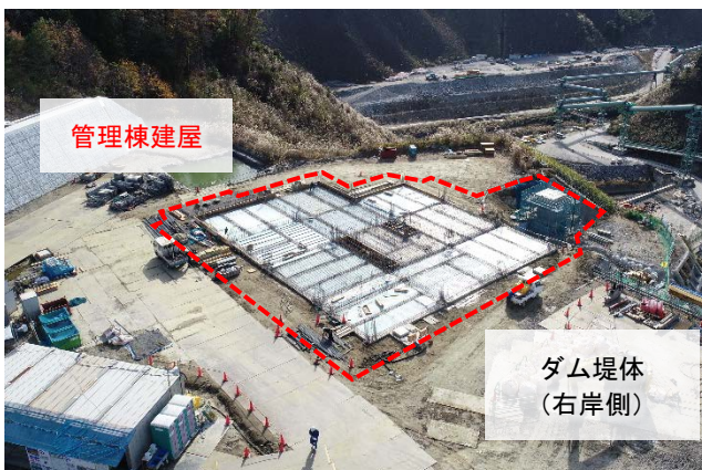
管理棟の進捗状況
