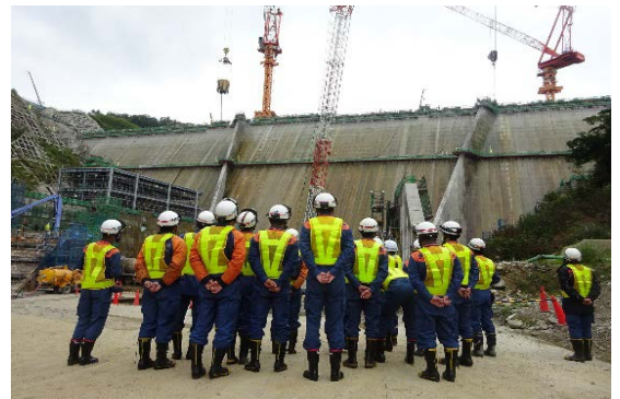
ダム直下流で現地視察中
