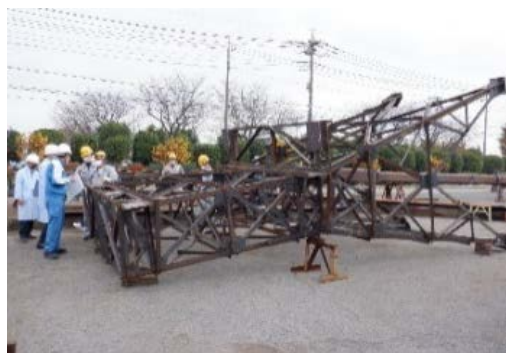
工場製作状況
