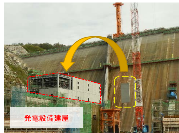
発電設備建屋のコンクリートパネル取り付けのようす
