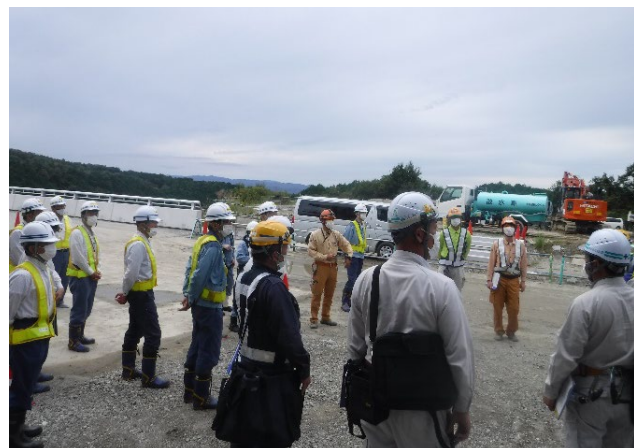
工事受注者も安全パトロールに参加いただきました
