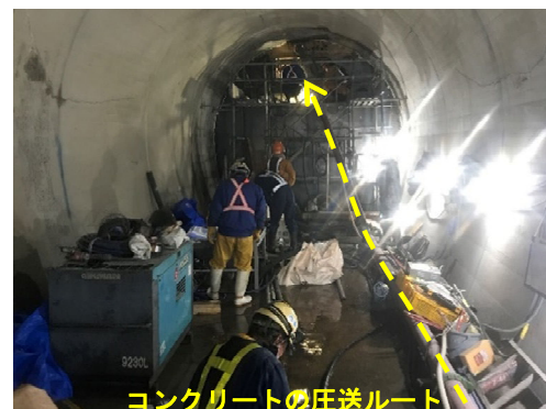
仮プラグのコンクリート打設のようす
