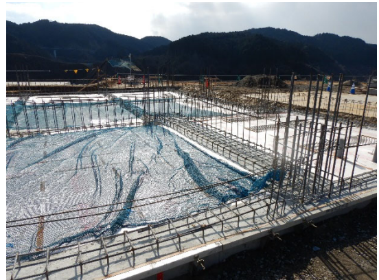
曝気設備建屋の基礎部分のようす
