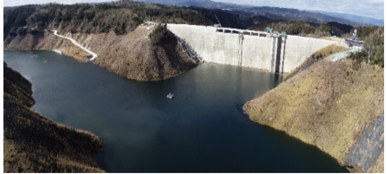
ダム直上流からダム堤体を撮影 (令和4年1月31日撮影)
