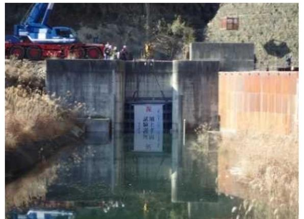
④仮排水路トンネル閉塞完了！
