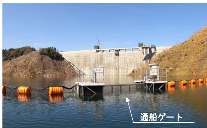
川上川よりみた流木止設備とダム堤体
