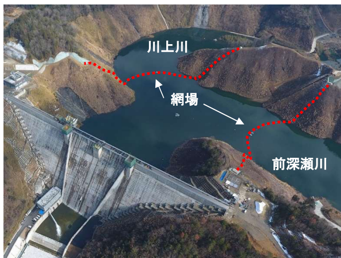
ダム上空からの写真
