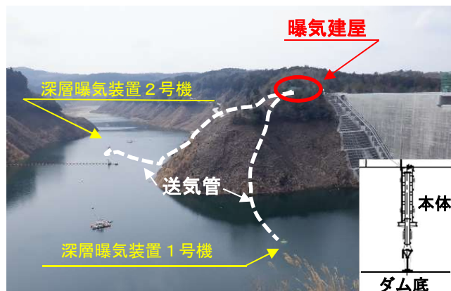
深層曝気装置の配置写真（右岸側より撮影）
