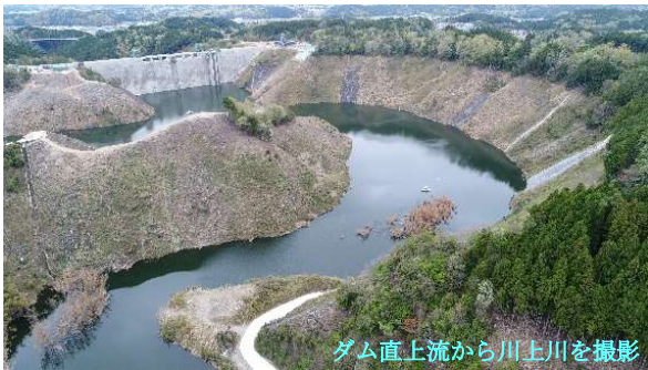
ダム直上流から前深瀬川を撮影
