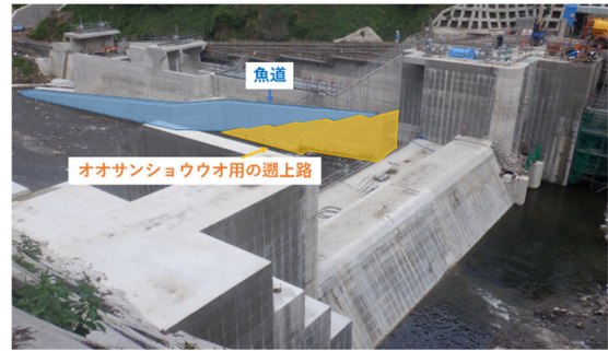
左岸上流部からの写真
