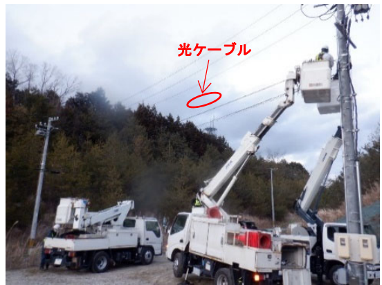
光ケーブル敷設のようす
