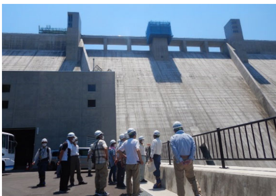
下流からダムを見学していただきました
