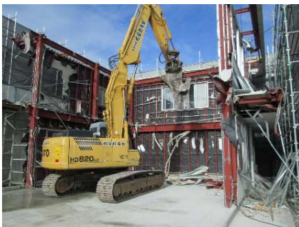
解体中の旧事務所
