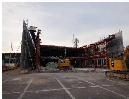
解体中の旧事務所
