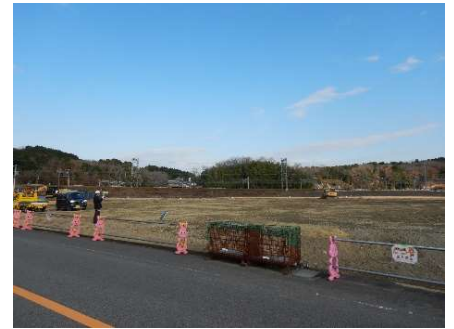
解体後の旧事務所
