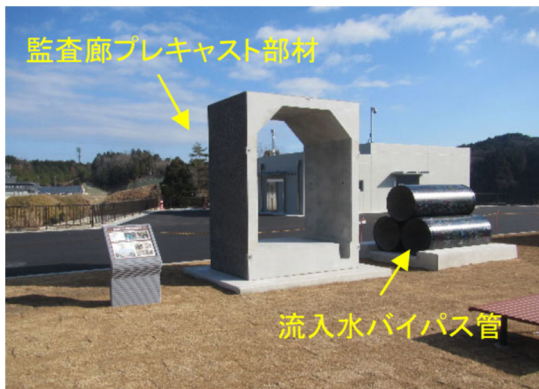
監査廊プレキャスト部材と流入水バイパス管（ダクタイル管）
