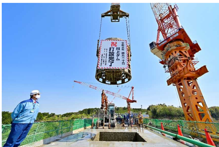
打設完了式の様子
