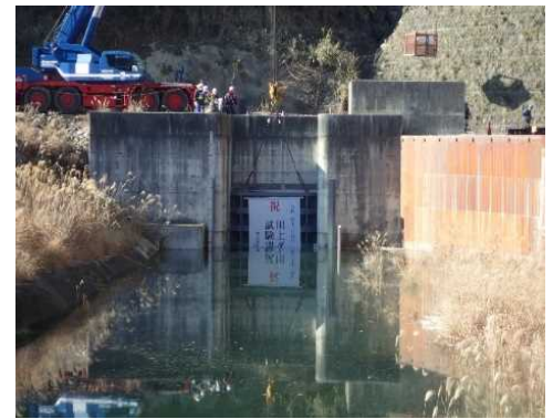
仮排水路トンネルの閉鎖後
