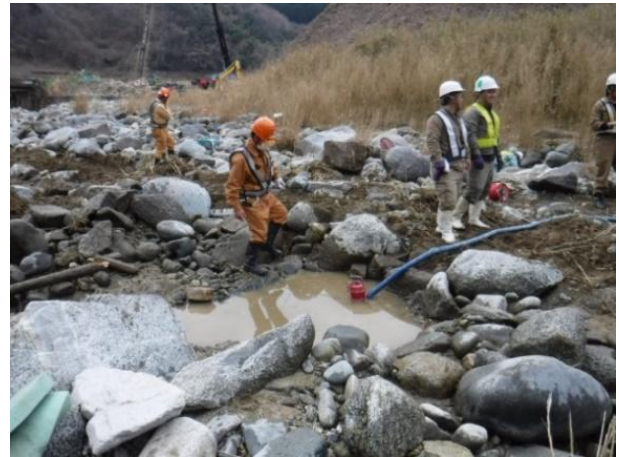
写真 4-2 ポンプアップによる水抜き
