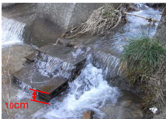
写真 4-7 落合井堰に設置した階段構造の遡上路 (コンクリートブロック)
