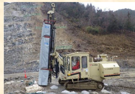
低騒音・低振動型建設機械の使用
