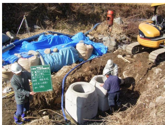
写真 4-16 施工中のマンホール型人工巣穴（重機使用）
