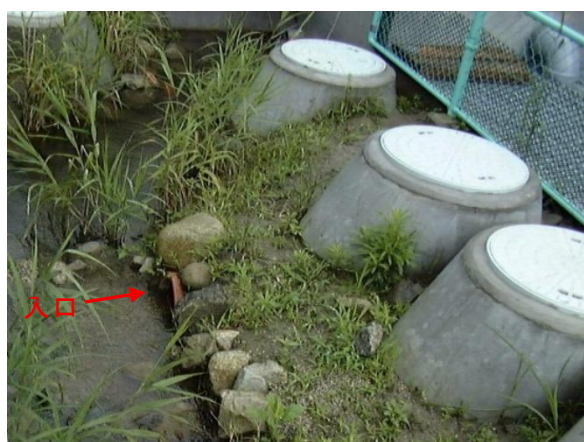
写真 3-19 第2保護池のマンホール巣穴
