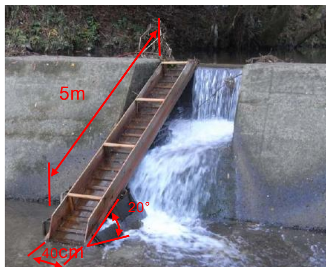
写真 4-6 砂田井堰に設置した斜面構造の遡上路 (木製スロープ)
