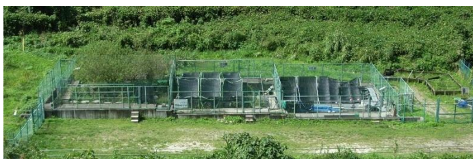
写真 3-17 第2保護池(左からA区画、B区画、C区画)
