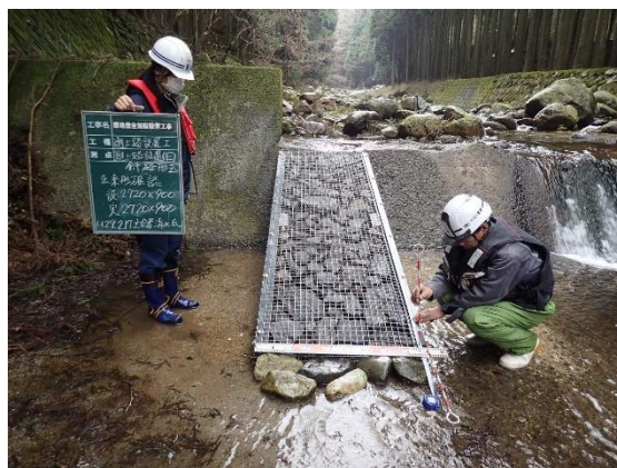
写真 4-12 遡上路 (斜路式) の設置状況
