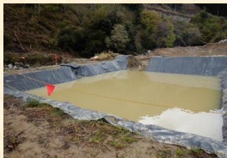
沈砂池の設置
