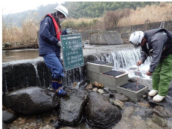
写真 4-11 遡上路 (階段式) の設置状況
