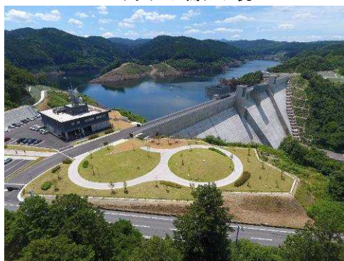
右岸天端広場
