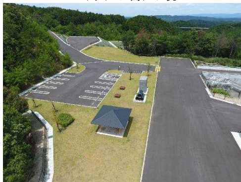
左岸天端広場
