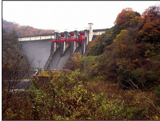
【ダム下流より室生ダムを望む】
