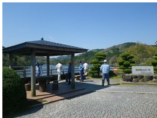
ダム天端広場点検状況
