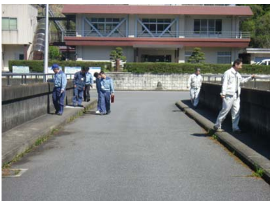
ダム堤頂道路点検状況
