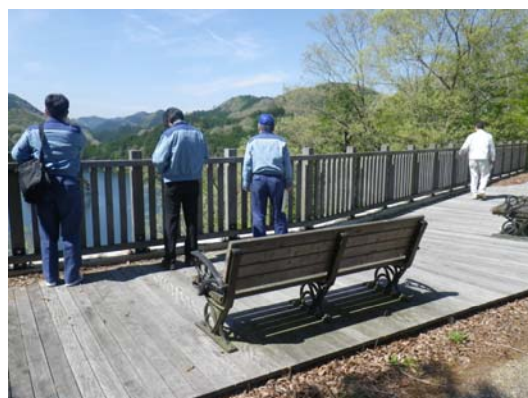
ダム展望台点検状況
