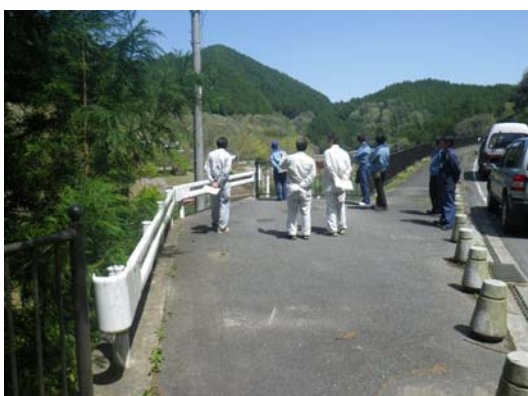
貯水池周辺(子供のもり公園)点検状況
