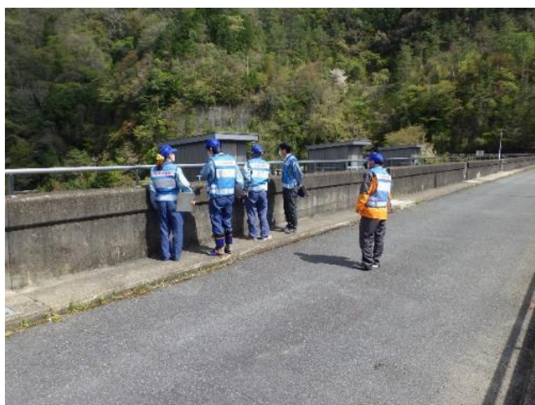
ダム堤頂道路点検状況
