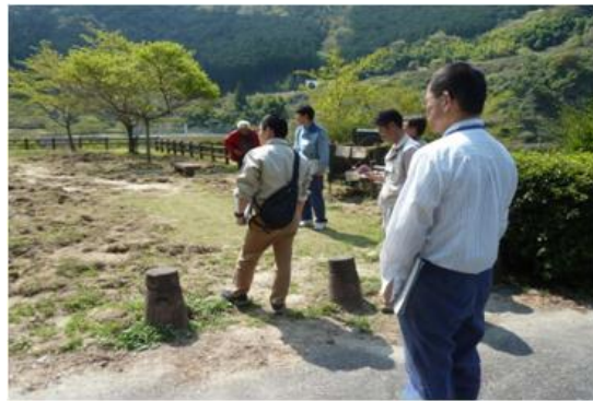
上流広場点検状況(青蓮寺ダム)
