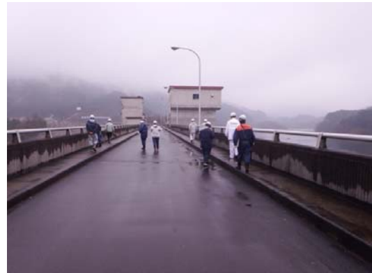
ダム天端点検状況(布目ダム)
