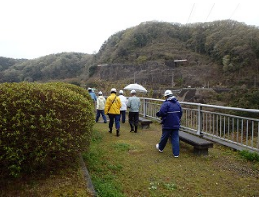
提体周辺広場の点検状況(高山ダム)
