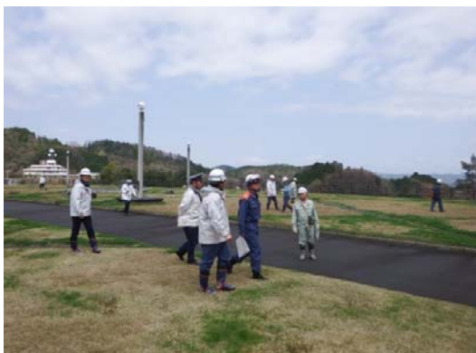
ダム右岸広場の点検状況（布目ダム）
