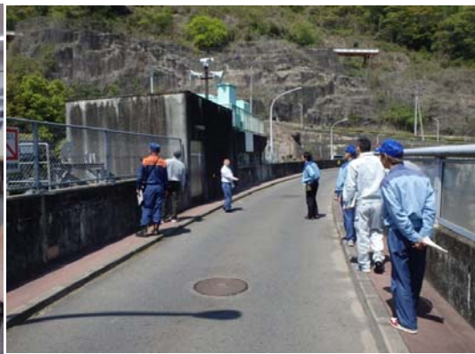
ダム天端道路の点検状況（高山ダム）
