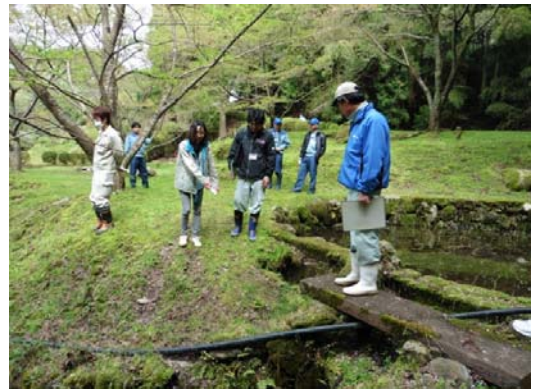
貯水池周辺の点検状況（青蓮寺ダム）
