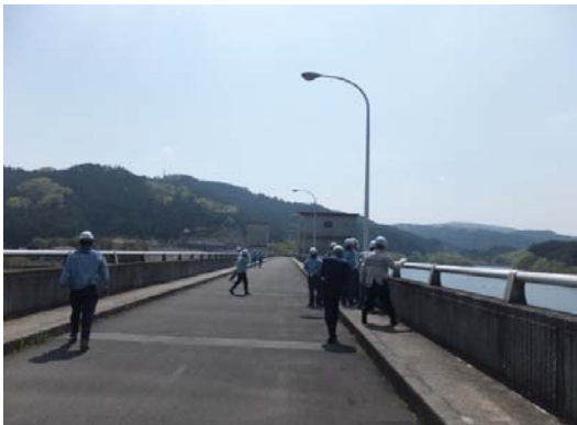
ダム堤頂部の点検状況（布目ダム）
