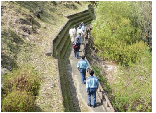
貯水池周辺の点検状況（青蓮寺ダム）
