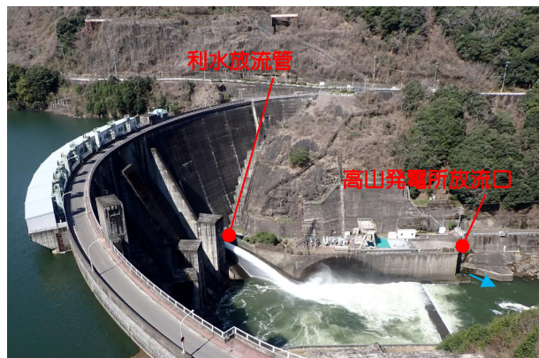
高山ダムの通常の放流状況 （利水放流管と高山発電所から放流）
