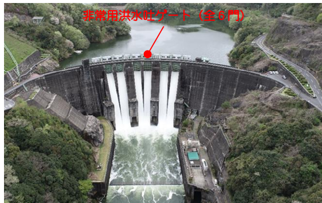
高山ダム非常用洪水吐ゲートからの放流状況 （令和5年4月のフラッシュ放流時の事例）
