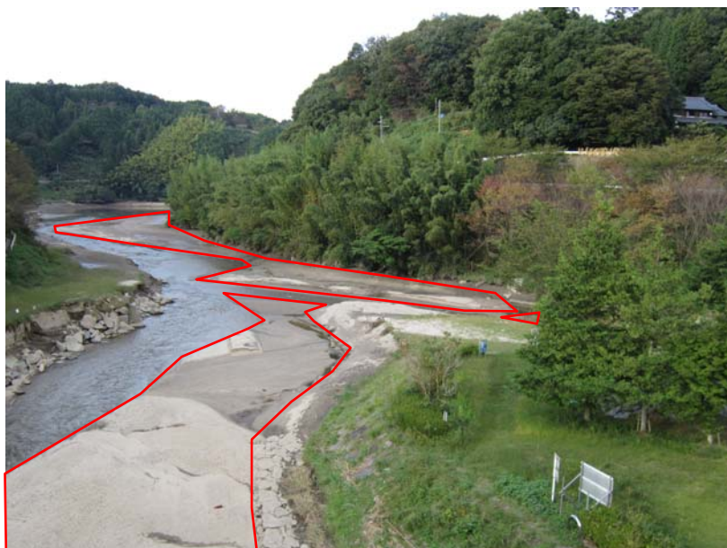
10月上旬の副ダム上流部の状況
