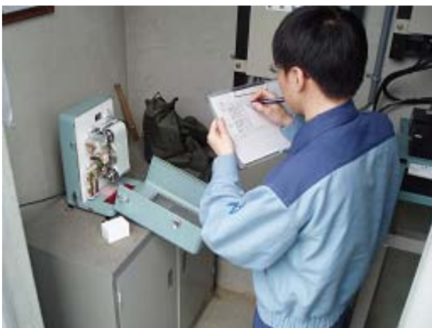
局舎内の機械の点検
