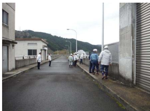
ダム天端広場点検状況
