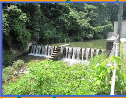
布目川取水堰で必要な水を取って残りは下流に流します。
