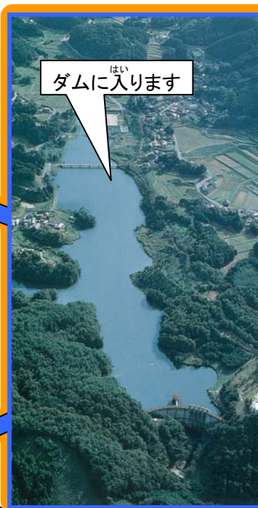
すがわ 須川ダム
