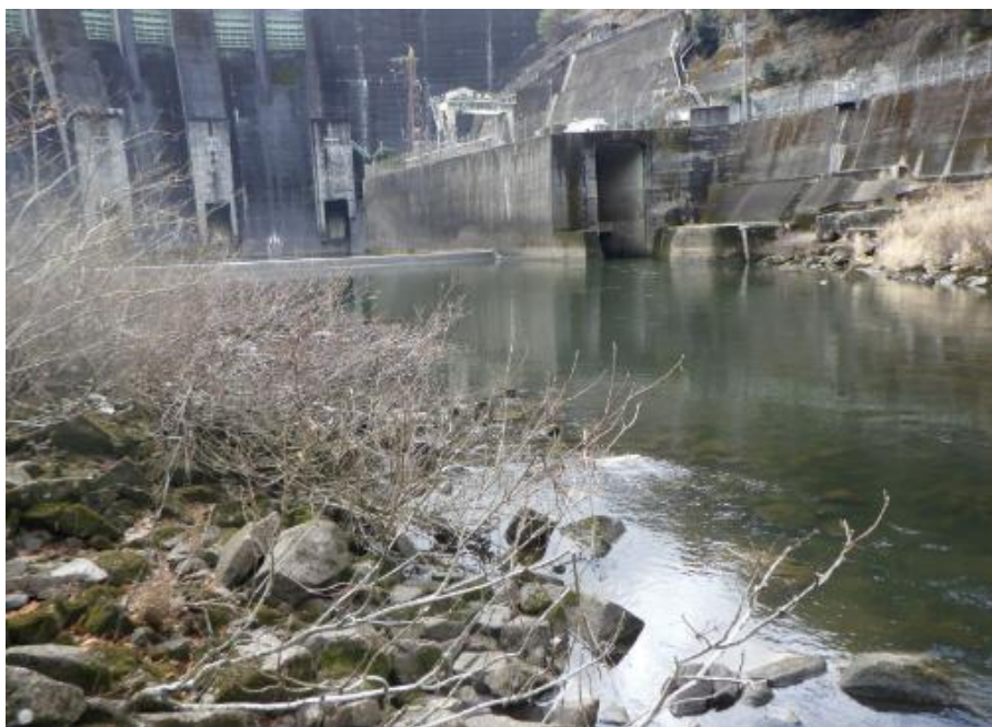
調査地点右岸から上流側を撮影
