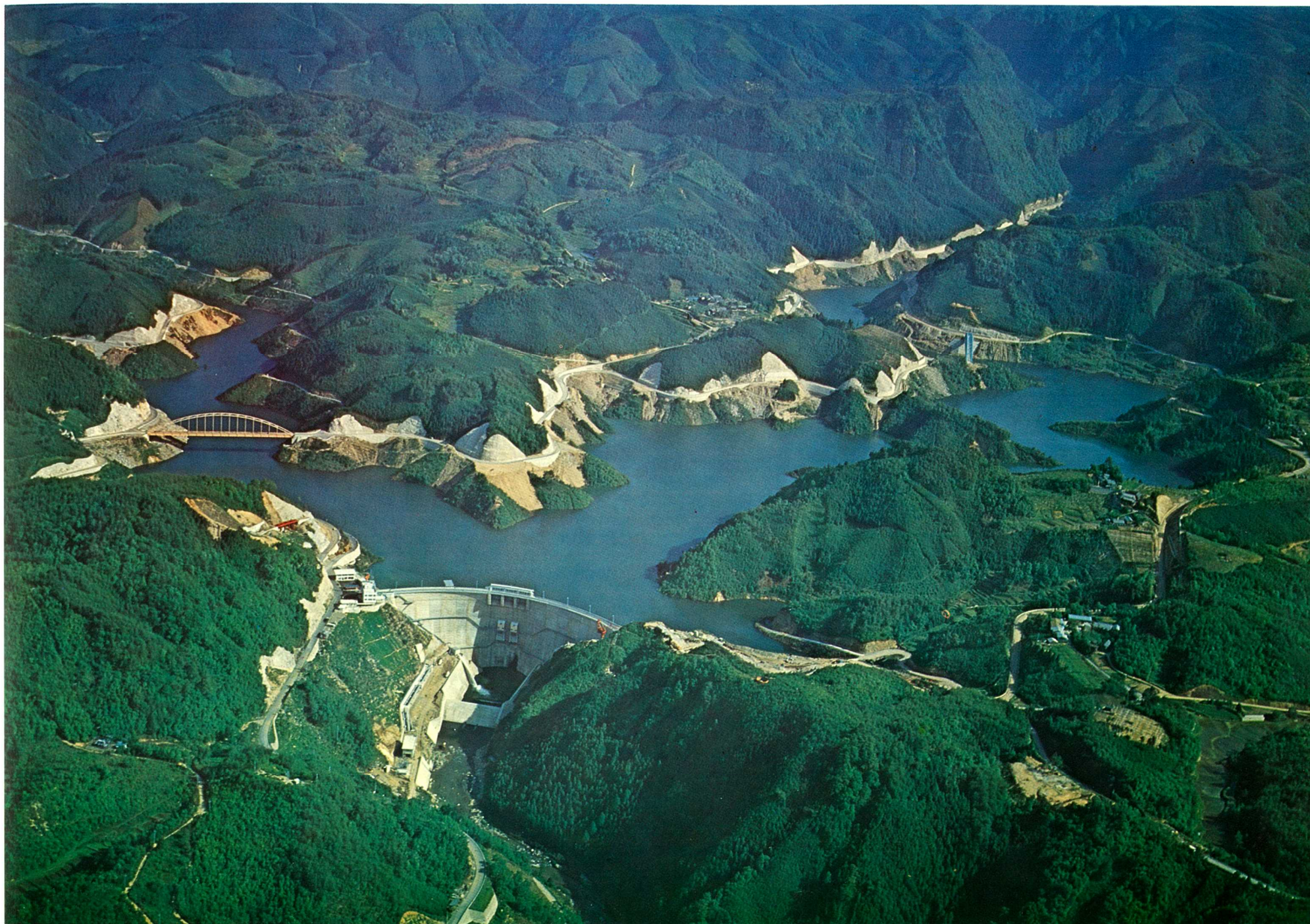
青蓮寺ダム全景
