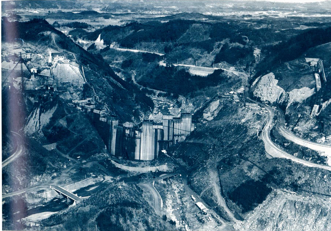
ダムサイト全景(44.2.)
