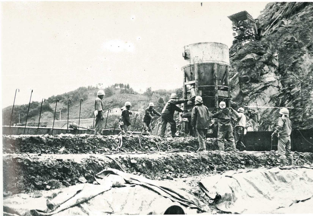
コンクリート打設
