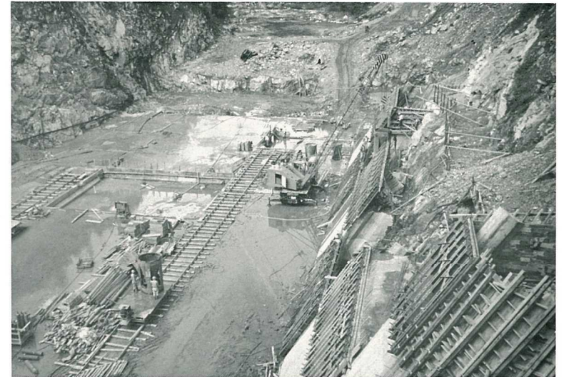
導流壁打設(44.2.)
