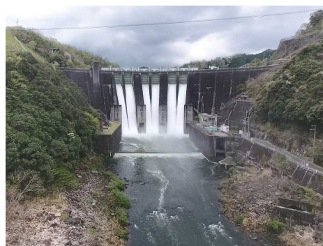
非常用洪水吐からの放流状況 （令和 3 年 4 月の事例）
