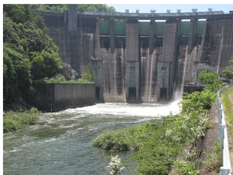
通常の放流状況（利水放流管）
