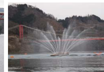
噴水設備(2ヶ所)
