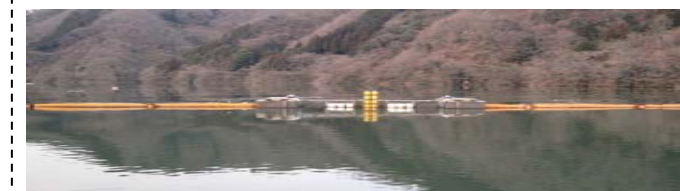
分画フェンス(1ヶ所)
