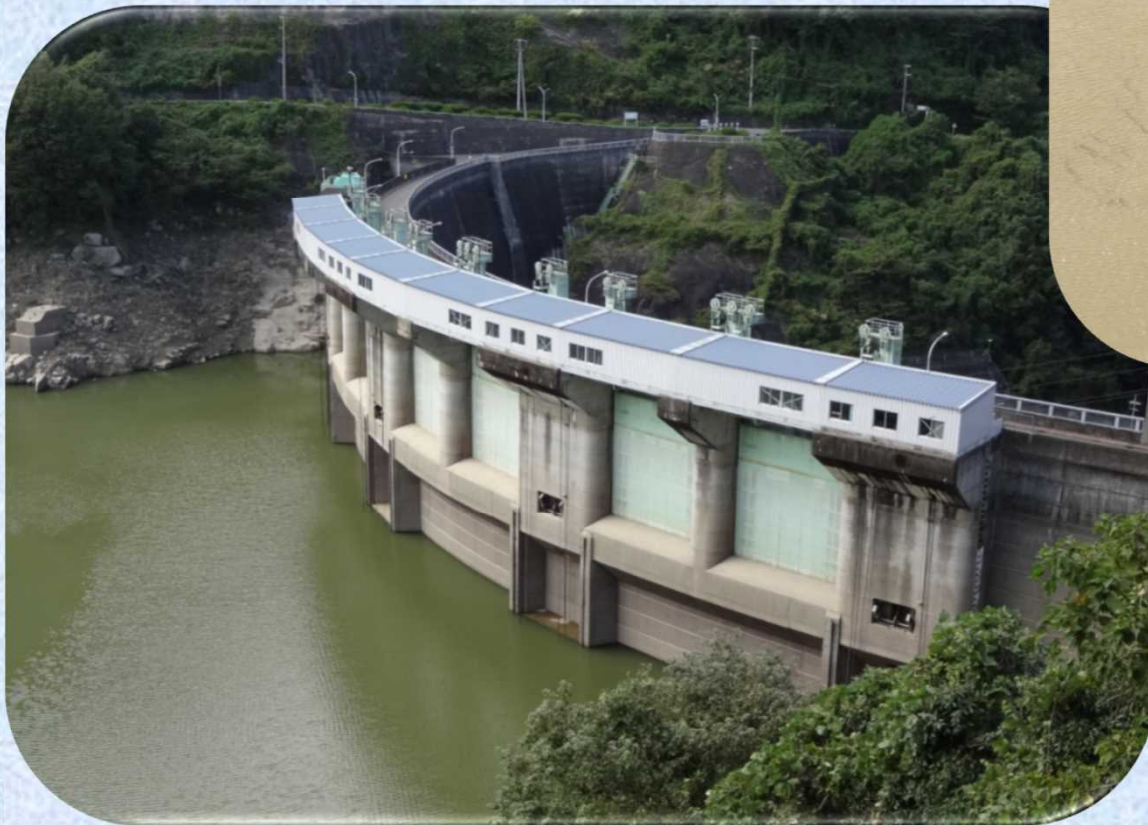
洪水調節直前の貯水池
