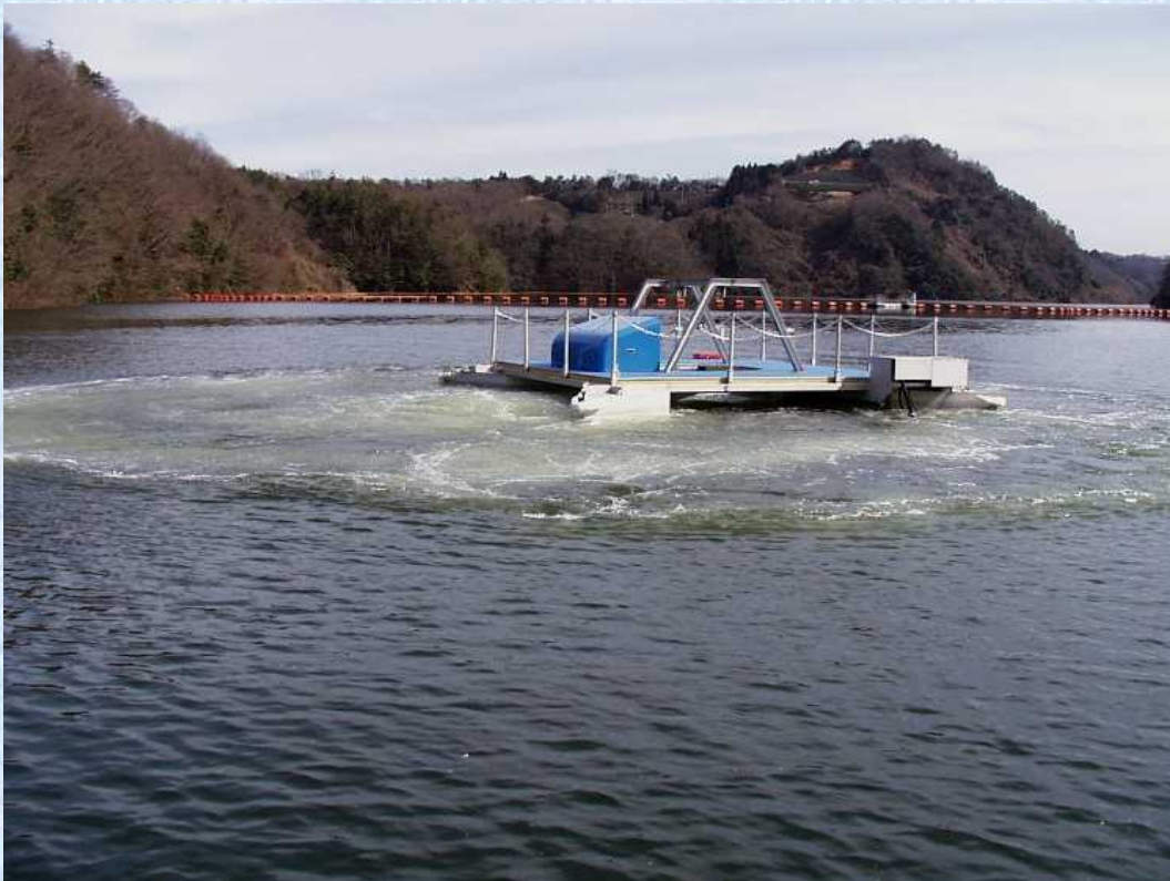
浅層循環設備
