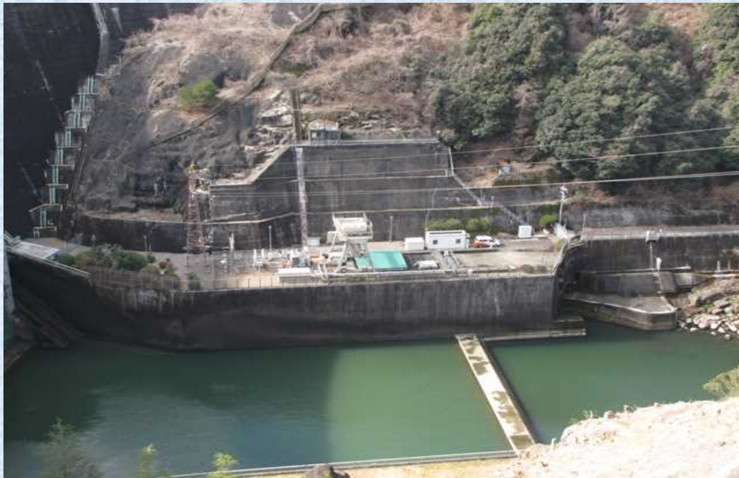
高山発電所全景
