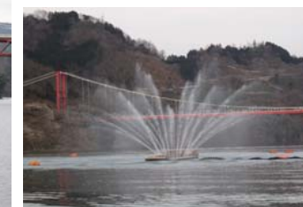
噴水設備(2ヶ所)
