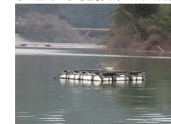
水道取水施設(1ヶ所)
