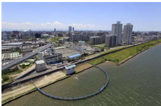
取水口と高見機場
