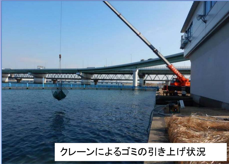
クレーンによるゴミの引き上げ状況
