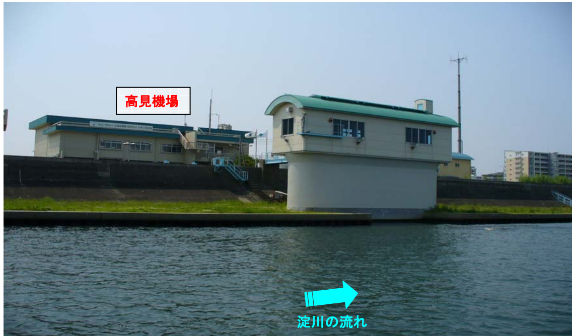
新淀川より、高見機場の取水口を望む
