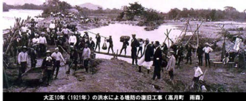
大正10年（1921年）の洪水による堤防の復旧工事（高月町 雨森）
