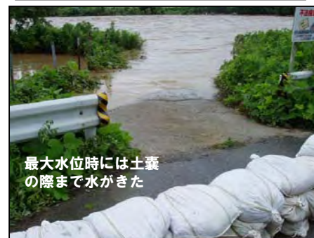
●高時川右岸 姉川大橋上流の水防活動
