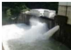
利水放流設備からの放流
